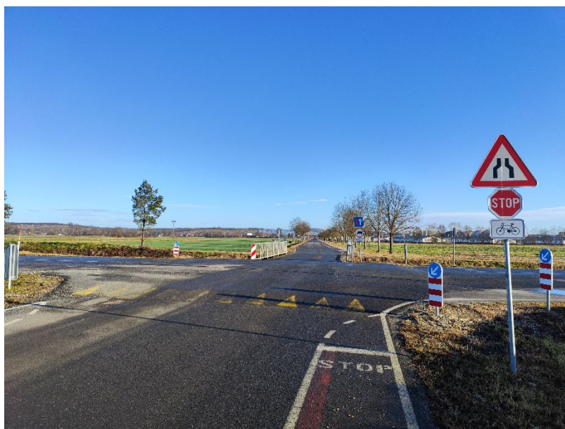
Slika 14: Urejeno denivelirano križišče za umirjanje prometa in povečanja varnosti kolesarjev ter pešcev na križišču LC-430031 Turnišče-Dobrovnik z občinsko javno potjo JP-707651 Radm. kanal-gramoznica
